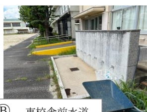
② 東校舎前水道
