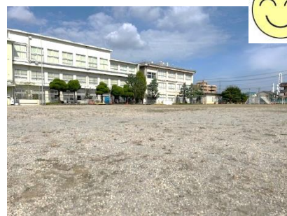
整備作業後の様子
