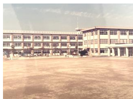
改修前の西校舎
