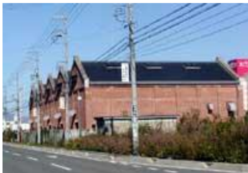
レンガ造りの倉庫跡
